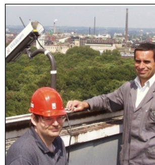
Montage in luftiger Höhe.
